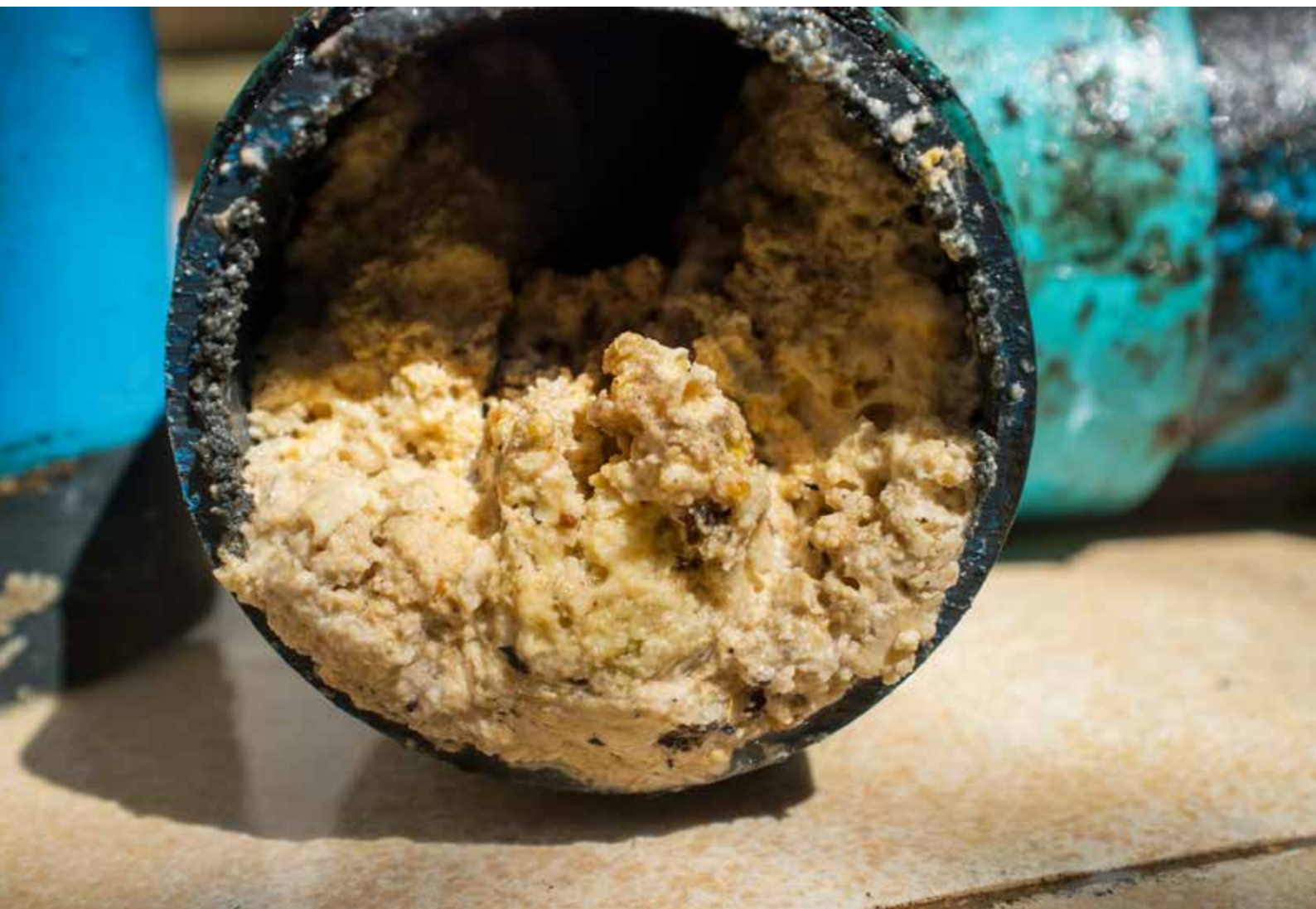
Una tubería taponada por el aceite y la grasa del así llamado «fatberg» o «iceberg de grasa» en el alcantarillado de Londres.
