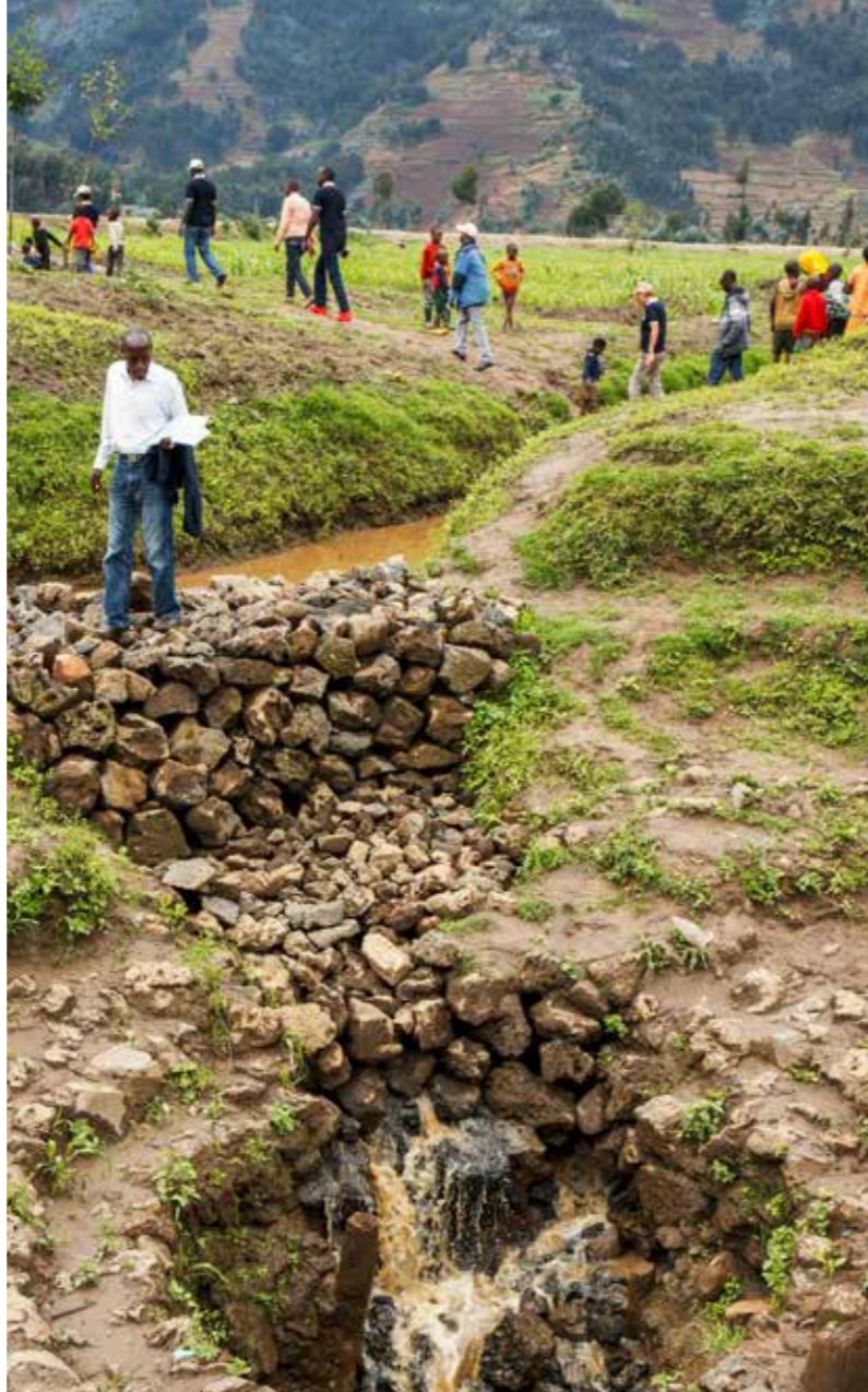
Un proyecto de drenaje de aguas pluviales en un valle propenso a inundaciones en la región volcánica del noroeste de Ruanda.
